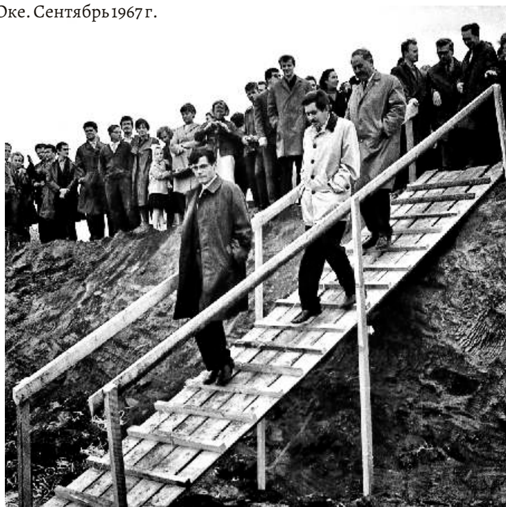
Закладка Института белка, Пущино-на-Оке. Сентябрь 1967 г.
